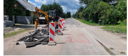
Budowa progu zwalniającego na ul. Szytniańskiej w Jarosławiu
