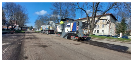
Przebudowa ul. Kościuszki w Jarosławiu_1
