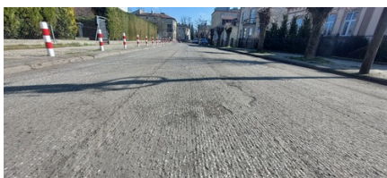
Przebudowa ul. Kościuszki w Jarosławiu
