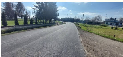
Wyrównanie podbudowy przy remoncie DP Nr 1674R Lubaczów - Laszki - Duńkowice w m. Korzenica
