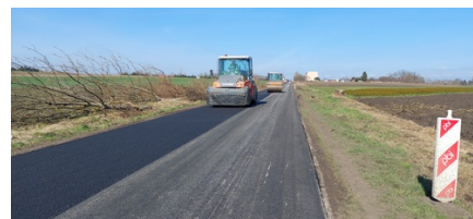
Wyrównanie podbudowy przy remoncie DP Nr 1674R Lubaczów - Laszki - Duńkowice w m. Korzenica_1
