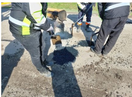
Uzupełnianie ubytków w nawierzchni masą w ciągu dróg i ulic powiatowych_2
