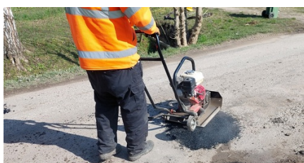
Uzupełnianie ubytków w nawierzchni masą w ciągu dróg i ulic powiatowych
