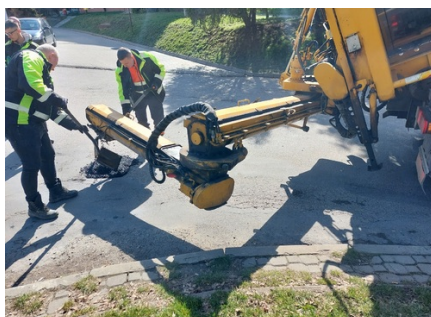
Uzupełnianie ubytków w nawierzchni masą w ciągu dróg i ulic powiatowych
