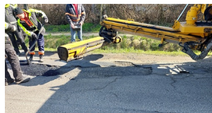
Uzupełnianie ubytków w nawierzchni masą w ciągu dróg i ulic powiatowych_1
