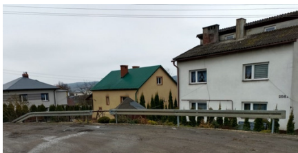
Ustawienie barier energochłonnych w ciągu DP Nr 1779R Droga przez wieś Kramarzędka_1
