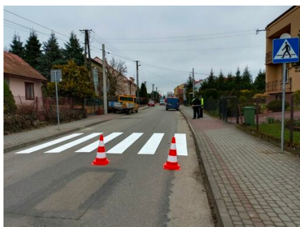
Wykonanie przejścia dla pieszych w ciągu DP Nr 1793R ul. 3-go Maja w Radymnie_2
