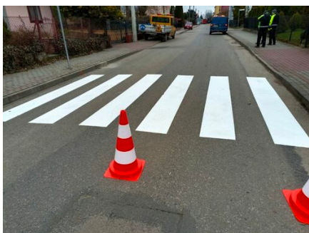
Wykonanie przejścia dla pieszych w ciągu DP Nr 1793R ul. 3-go Maja w Radymnie_1
