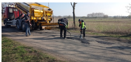
Uzupełnianie ubytków w nawierzchni masą w ciągu dróg powiatowych Powiatu Jarosławskiego_4
