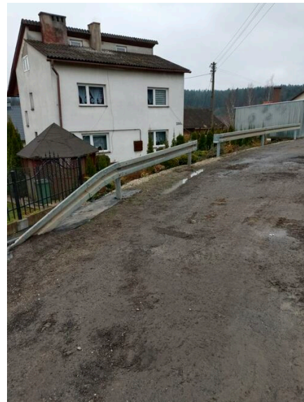
Ustawienie barier energochłonnych w ciągu DP Nr 1779R Droga przez wieś Kramarzędka
