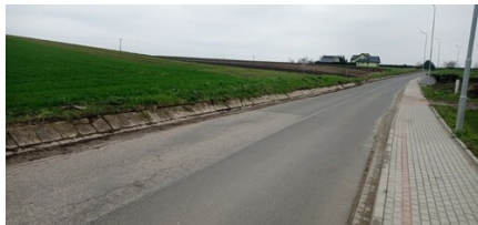
Oczyszczenie korytek w ciągu DP Nr 1820R Radymno - Walawa - Przemysł w m. Święte_1
