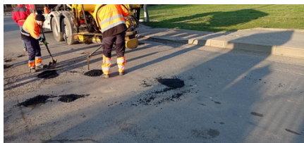
Uzupełnianie ubytków w nawierzchni masą w ciągu dróg powiatowych Powiatu Jarosławskiego
