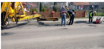
Uzupełnianie ubytków w nawierzchni masą w ciągu dróg powiatowych Powiatu Jarosławskiego_2
