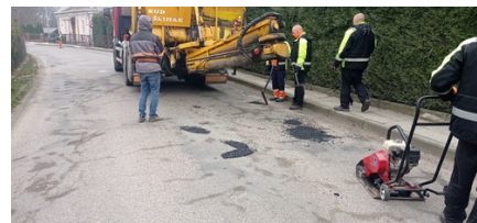
Uzupełnianie ubytków w nawierzchni masą w ciągu dróg powiatowych Powiatu Jarosławskiego_1
