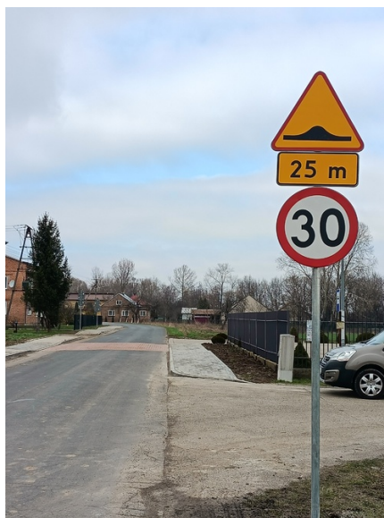
Budowa przejścia dla pieszych w miejscowości Kostków w ciągu DP Nr 1701R- Gorzyce - Kostków - Pełkinie_1
