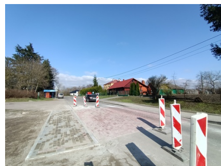
Budowa przejścia dla pieszych w miejscowości Łazy w ciągu DP Nr 1674R- Lubaczów-Łaszki-Duńkowice
